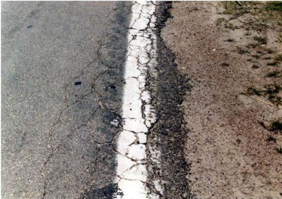
Edge Cracking
